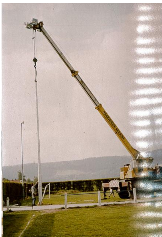
Aufstellung der Flutlichtanlage – Archiv SCL
